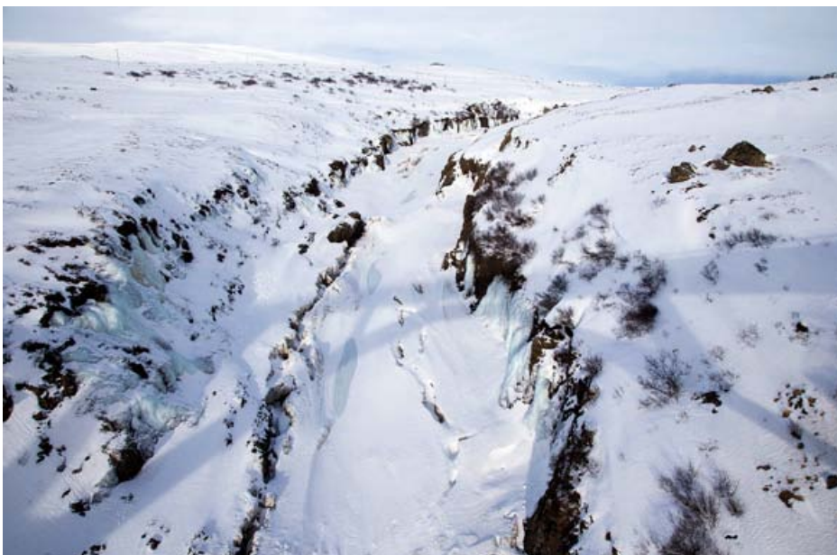
Viaduc sur la Jökulsá
